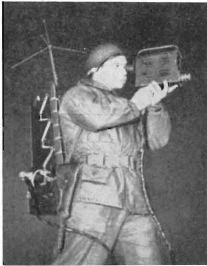
Questa è una completa stazione trasmittente televisiva costruita dal Signal Corps per impieghi militari.
